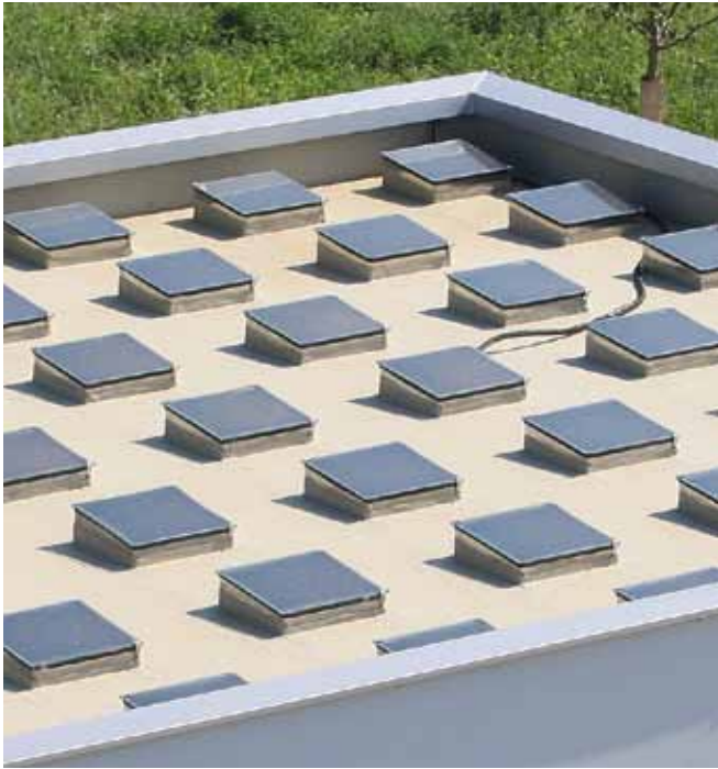
Die Firma Empl Baupenglerei und Flachdachbau GmbH aus Altötting hat 49 Lichtkuppeln auf der 7 mal 7 Meter großen Dachfläche abgedichtet. Mit Triflex ProDetail und Triflex ProFibre konnten Details und Übergänge, Kabeldurchdringungen und der Attikaanschluss homogen in die Fläche eingebunden werden.
